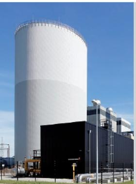
Der neue Fernwärmespeicher in unmittelbarer Nähe zum Kraftwerksblock erhöht die Flexibilität der Strom- und Wärmeerzeugung und macht sie dadurch noch klimafreundlicher. Er wurde 2017 in Betrieb genommen.
