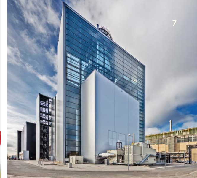
Gaskraftwerk der Stadtwerke Düsseldorf: Block „Fortuna“
